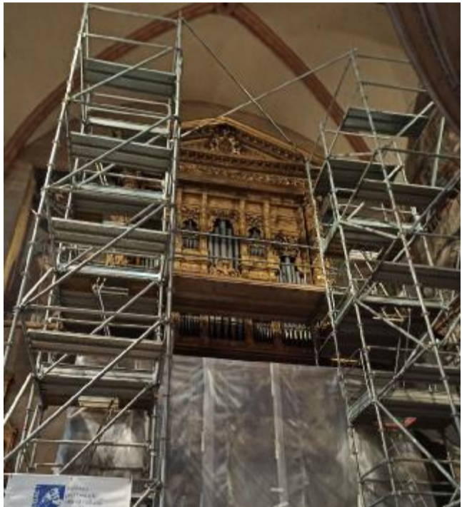
Il restauro Il ponteggio montato durante i lavori
