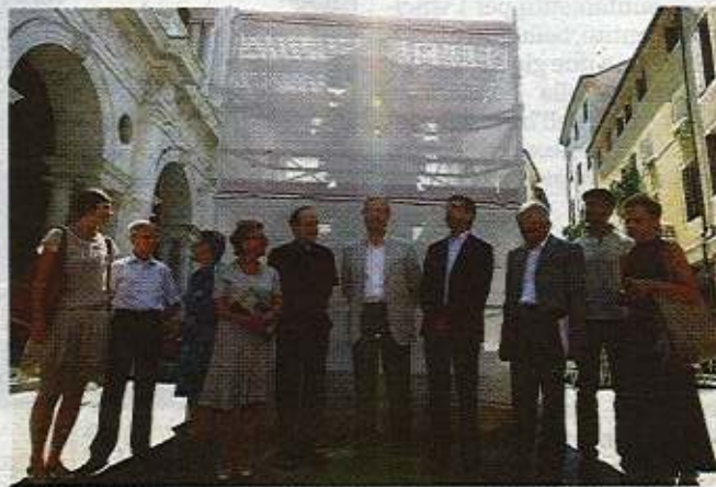
Amministratori comunali e Amici dei monumenti visitano il cantiere
