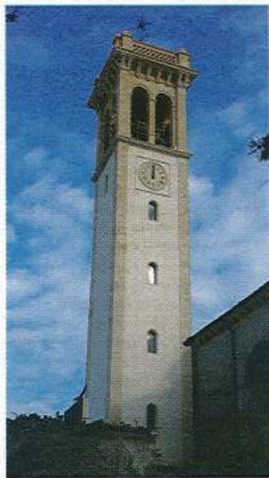
La torre campanaria della chiesa di SS. Trinità di Montecchio Maggiore, dopo le importanti opere di restauro. Sopra una foto del cantiere
